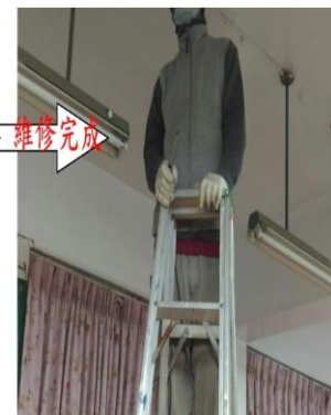
107.02.08 805班 整座燈具 已損-許清守.換修過程
