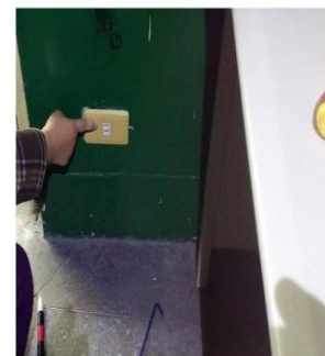
開關已維修完成
