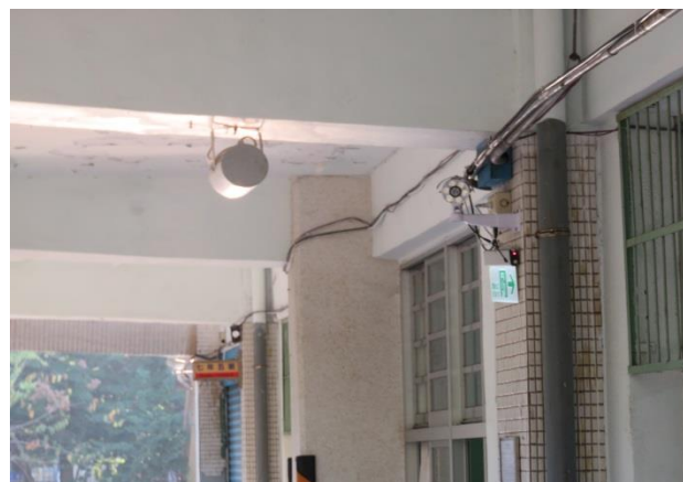
校內監視器增設-施工後
