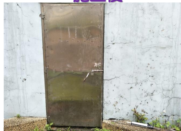
逐風廣場圍牆鐵門修理- 施工後
