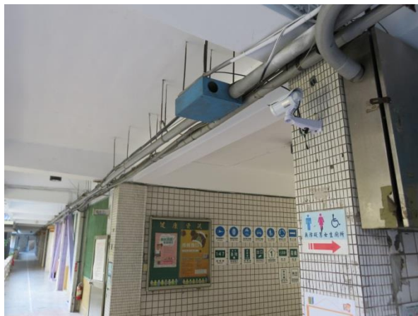
校內監視器增設-施工後
