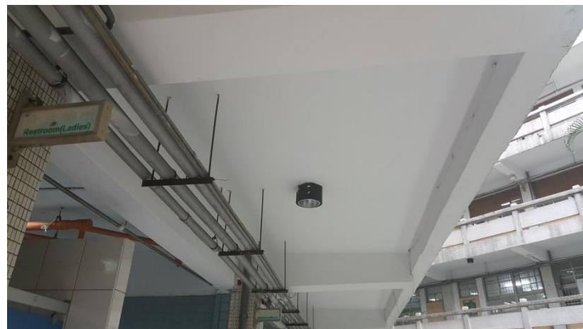
天花板修補-施工後
