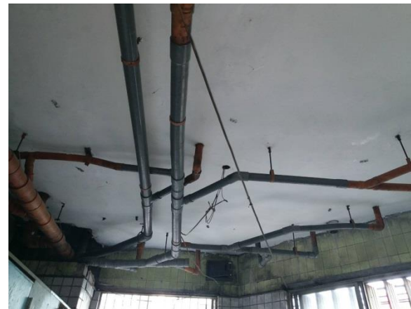
天花板修補-施工後
