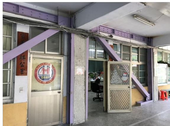
校舍補強-施工後
