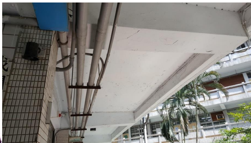
天花板修補-施工前
