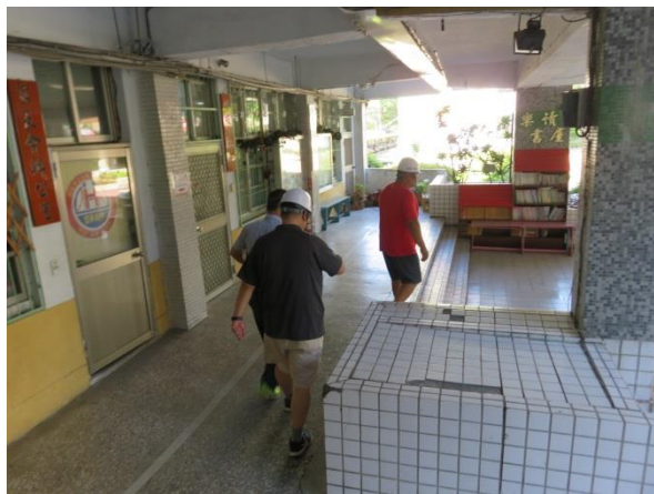
校舍補強-施工前
