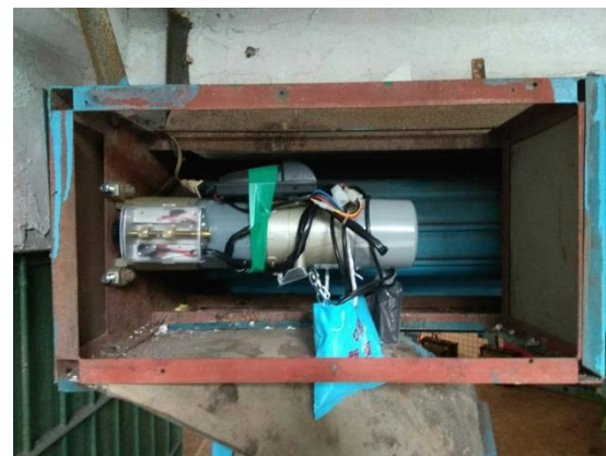
和平樓鐵捲門維修- 施工後
