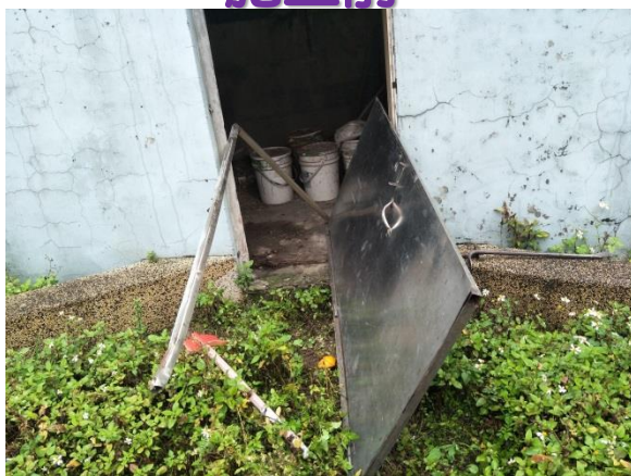
逐風廣場圍牆鐵門修理- 施工前
