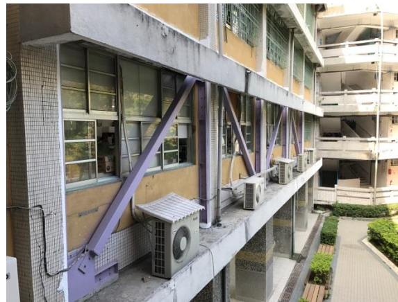
校舍補強-施工後
