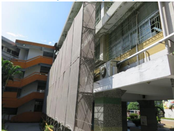
校舍補強-施工前
