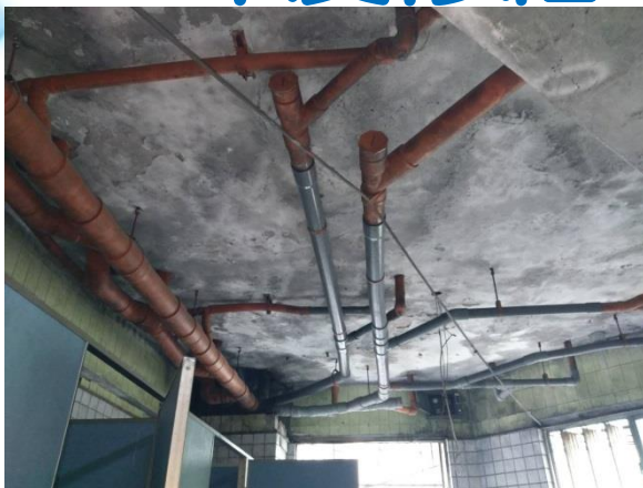
天花板修補-施工前
