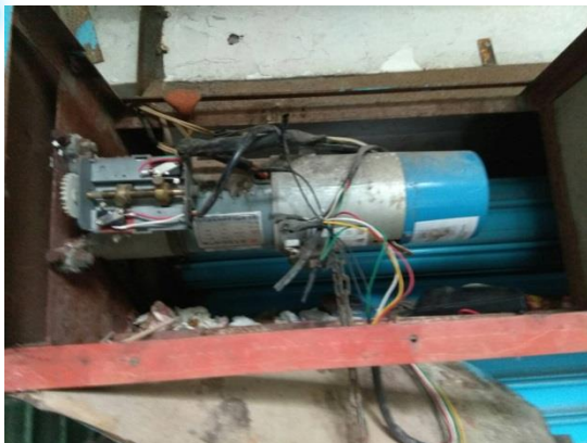
和平樓鐵捲門維修- 施工前
