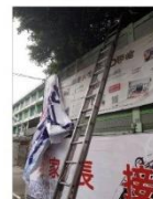
多元展能施工起
