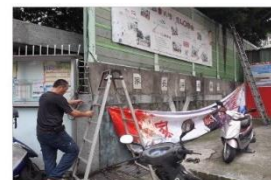
家長接送區施工起
