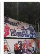
多元展能施工中
