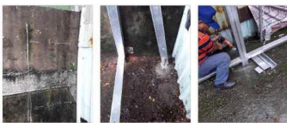
約50公分處做隔離
