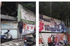
家長接送區施工中
