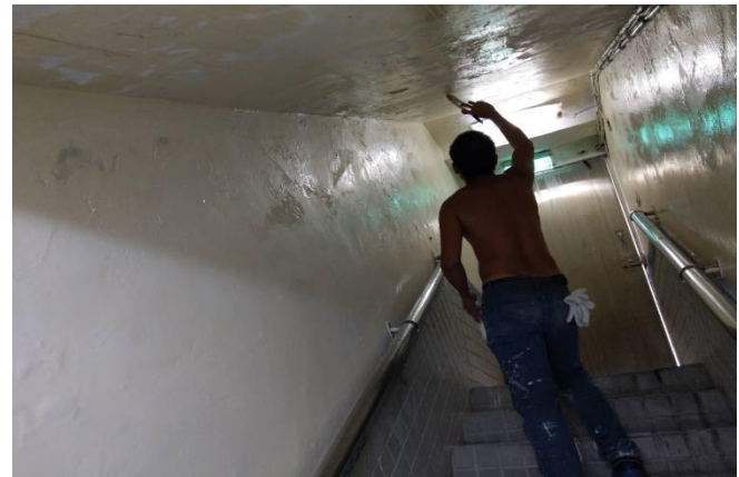
四維樓會議室牆面油漆粉刷
