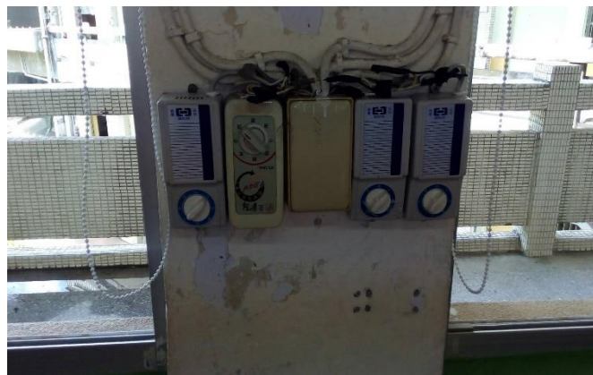
電風扇開關更換
