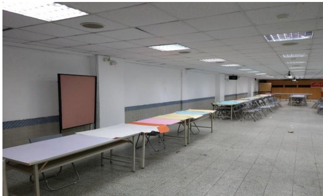
四維樓會議室牆面油漆粉刷
