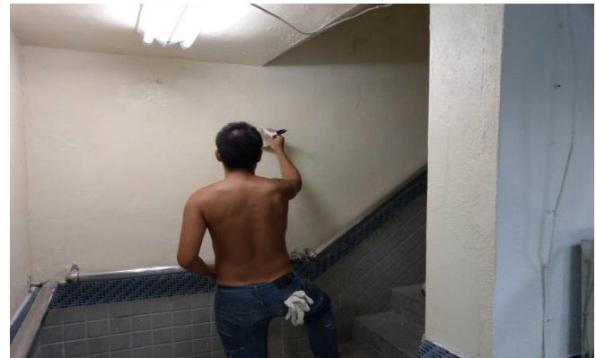
四維樓會議室牆面油漆粉刷
