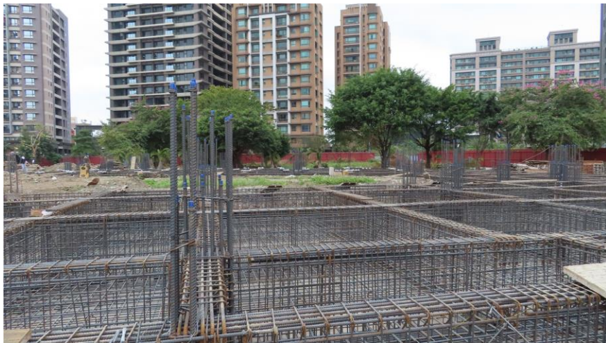
教學大樓基礎板鋼筋綁紮
