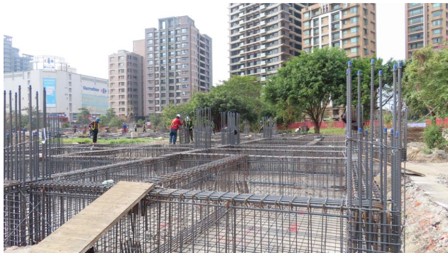
教學大樓基礎板鋼筋綁紮
