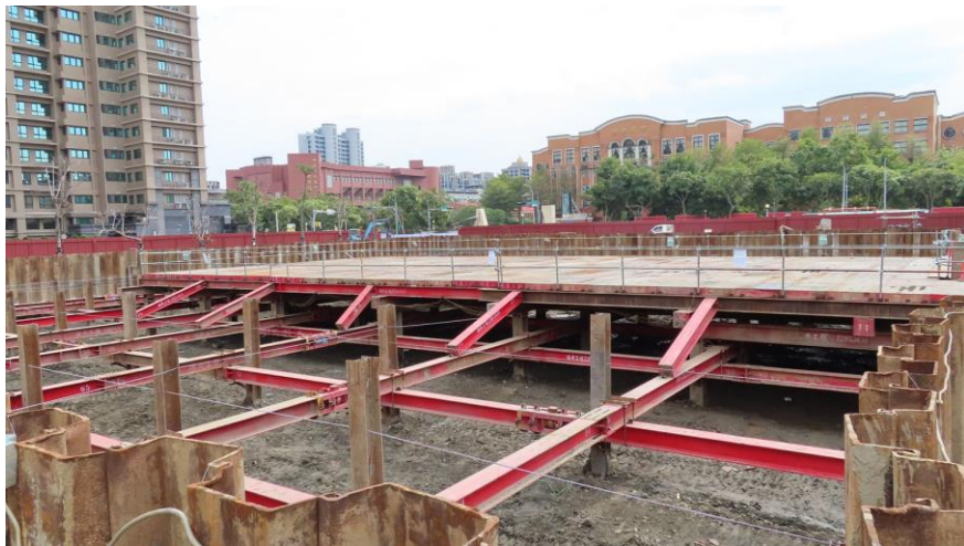
安全支撐及施工構台-施作完成
