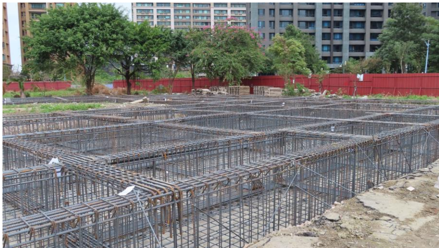
教學大樓基礎板鋼筋綁紮
