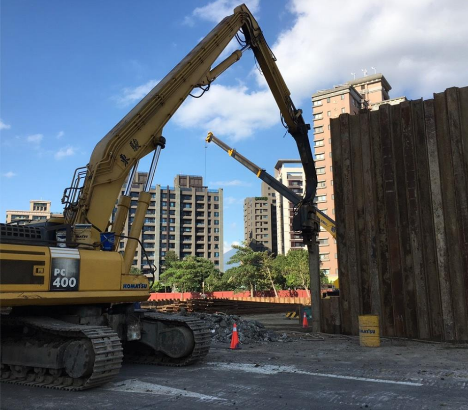
鋼板樁施工
