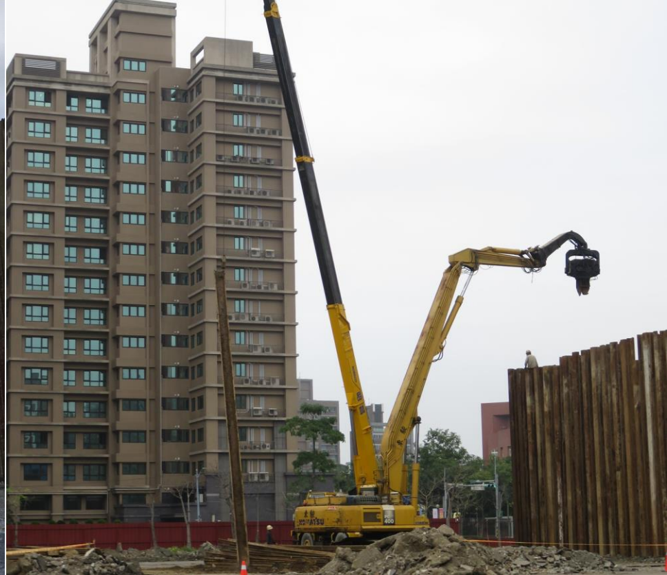
鋼板樁施工
