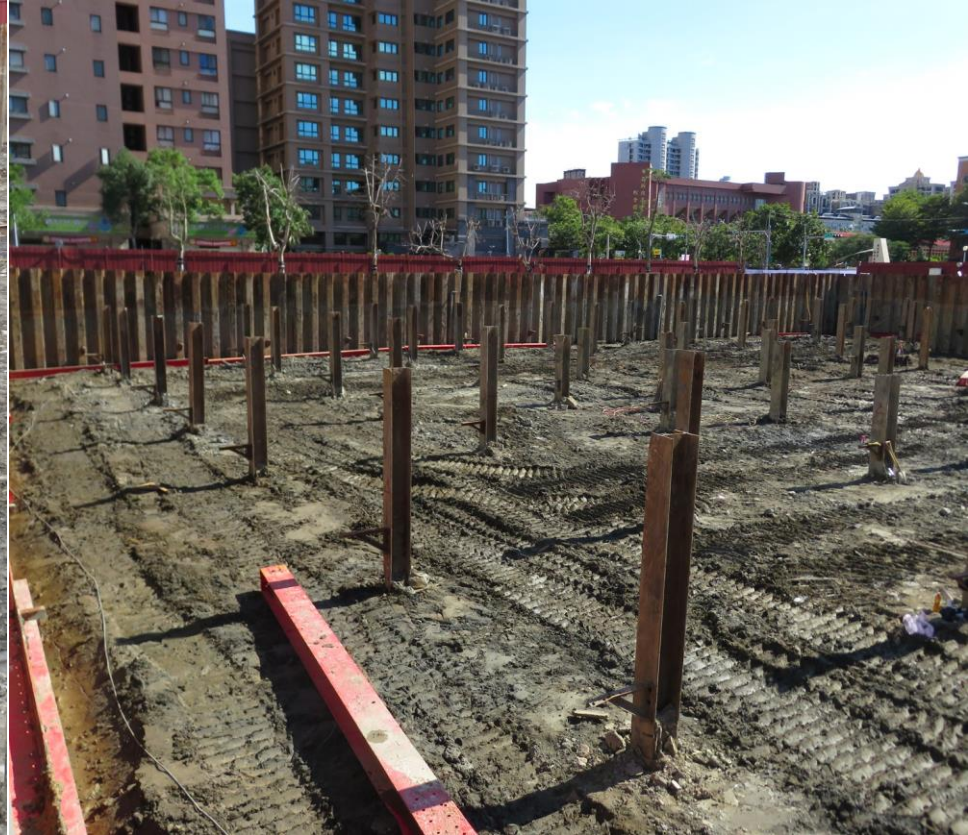
安全支撐與施工構台
