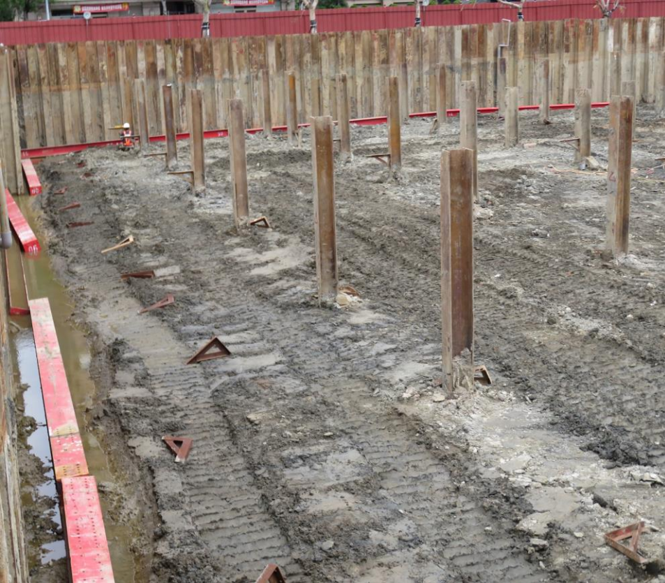
安全支撐與施工構台
