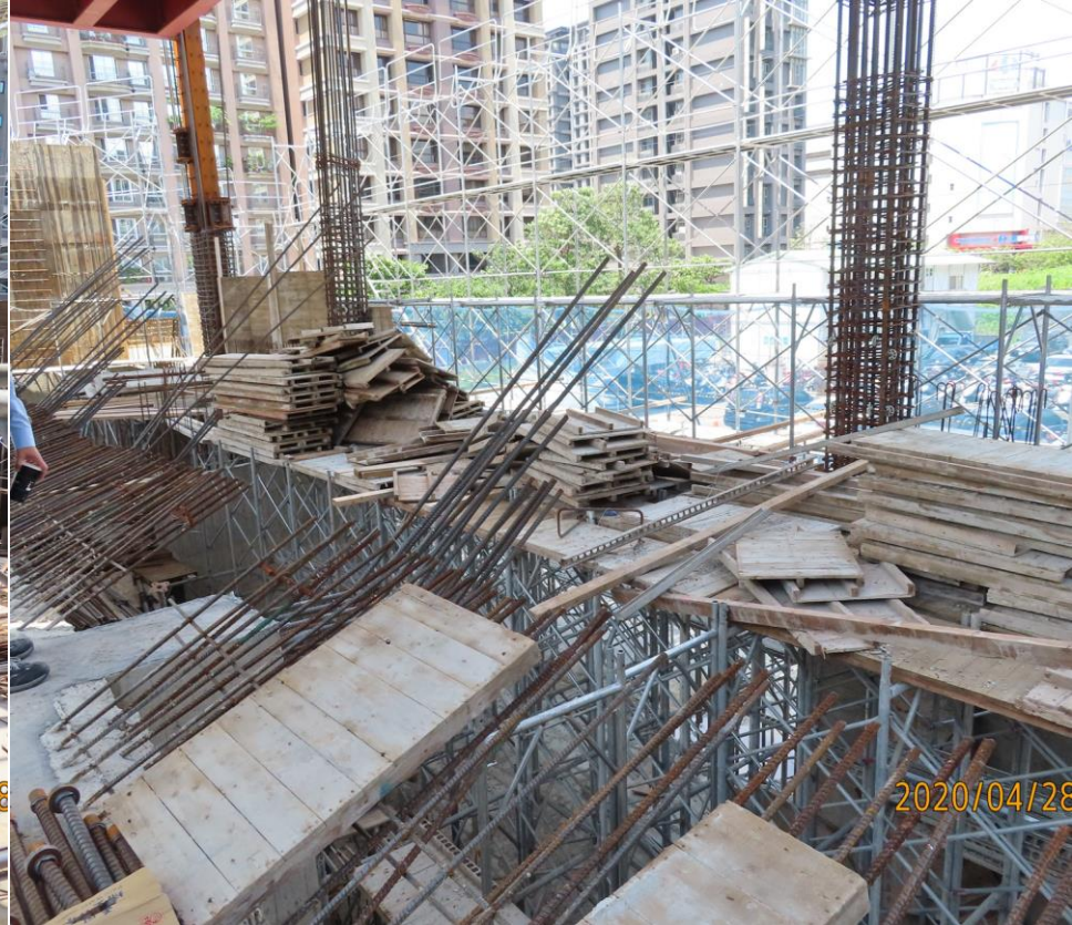
活動中心舞台版灌漿及看台鋼筋模板配置
