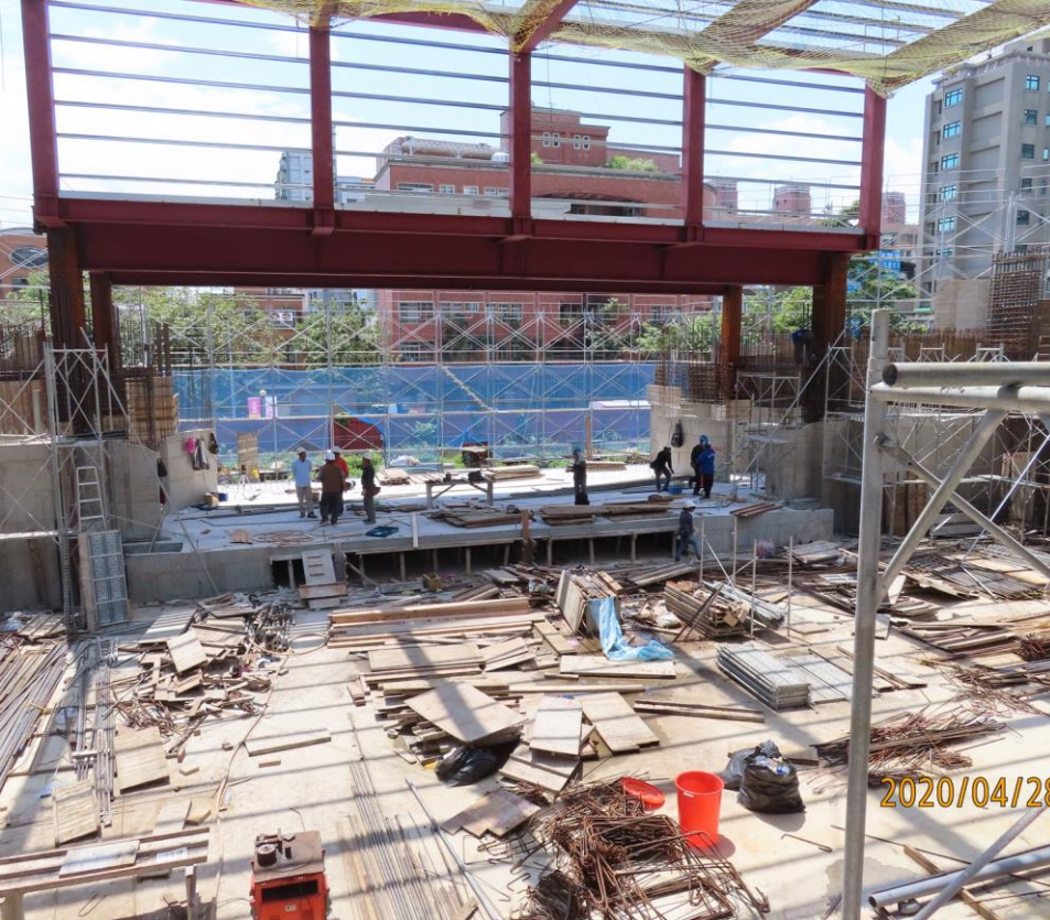
活動中心舞台版灌漿及看台鋼筋模板配置
