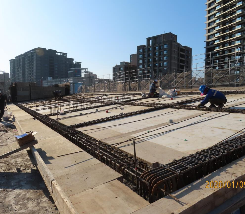
教學RF頂樓斜屋頂鋼筋綁紮
