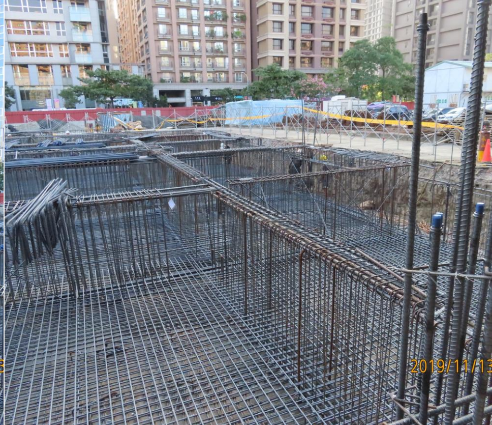
活動中心基礎版地梁柱鋼筋綁紮
