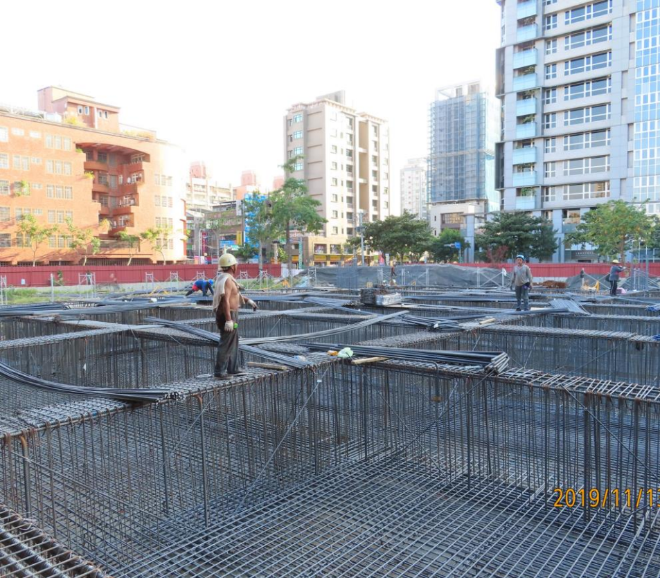
活動中心基礎版地梁柱鋼筋綁紮
