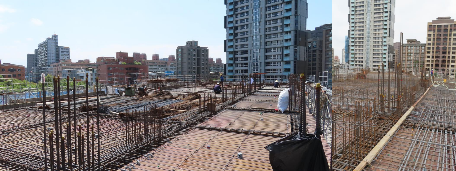
教學大樓4樓樑版模施工作業及完成
