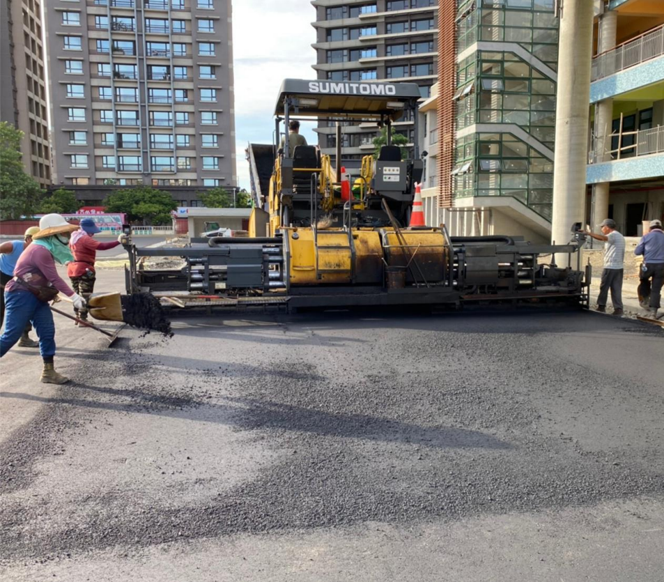
操場瀝青混凝土鋪面施作
