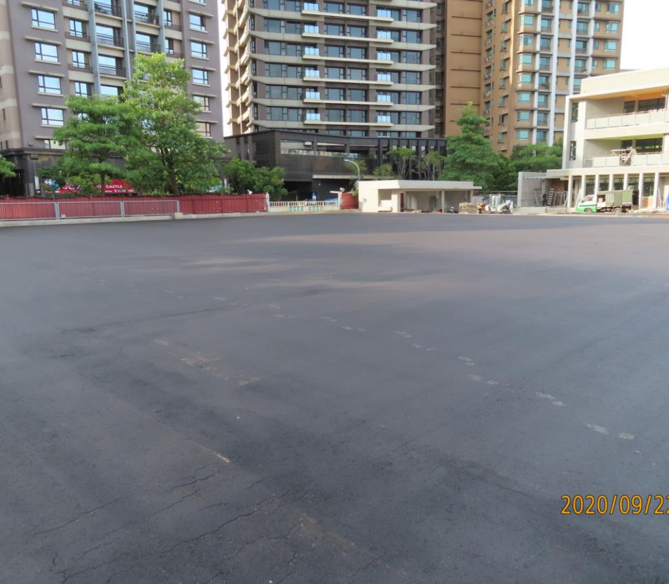
網球場瀝青混凝土鋪面施作
