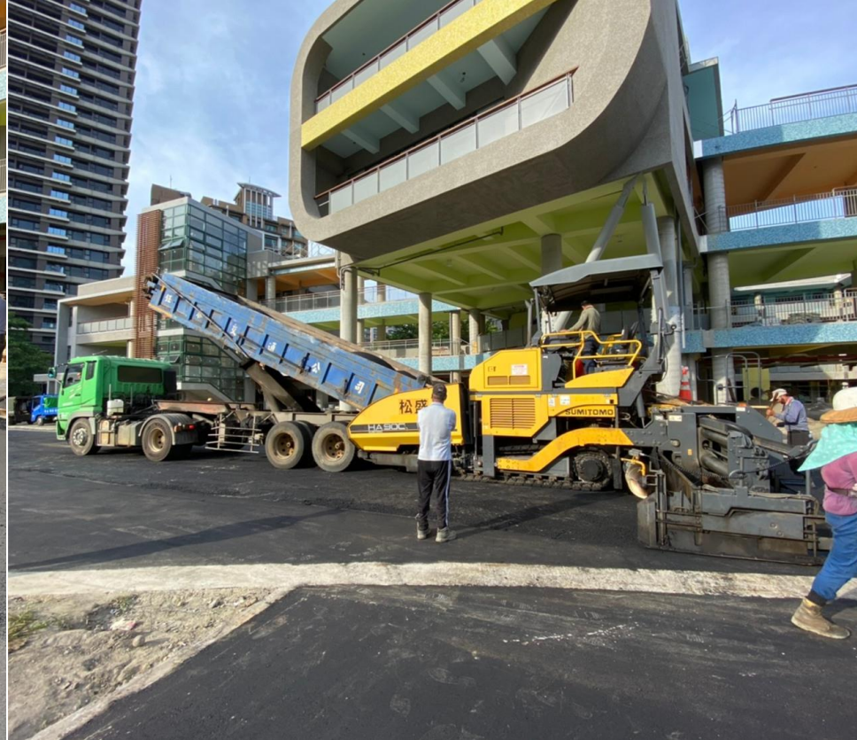
操場瀝青混凝土鋪面施作
